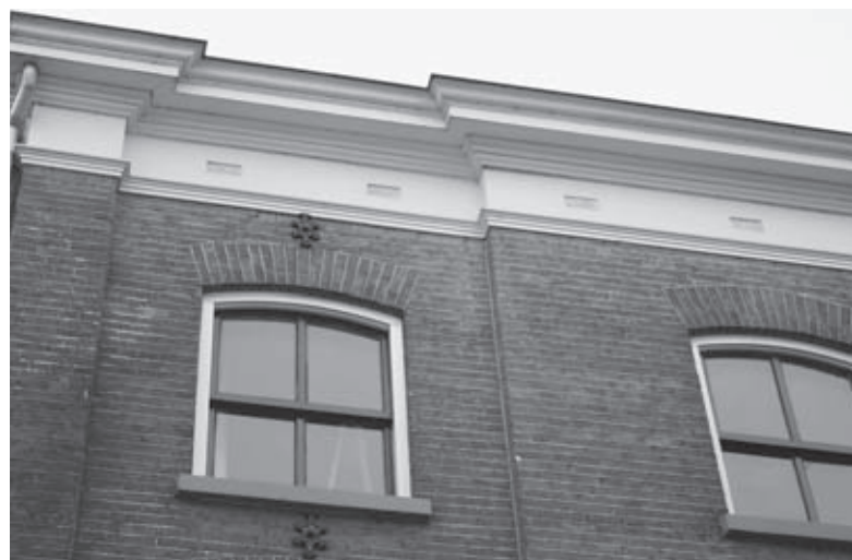
▲ Detail van de voorgevel van Oude Wand 130-132 met ventilatieroosters opgenomen in het fries. Foto Jeroen Krijnen – gemeente Zutphen
