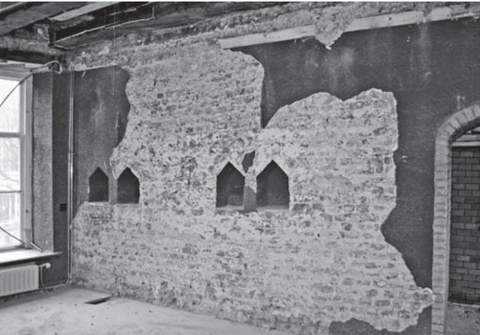
▲ De gemeenschappelijke bouwmuur tussen Groenmarkt 33 en 35 is 60 centimeter dik, hier gezien vanuit nummer 35. De muur, de balklagen, vloerhoogten en kaarsnissen dateren in hun onderlinge samenhang uit de 14e eeuw.
