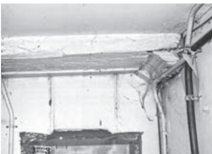
▲ Detail van de enkelvoudige balklaag met console onder de tweede verdieping.
