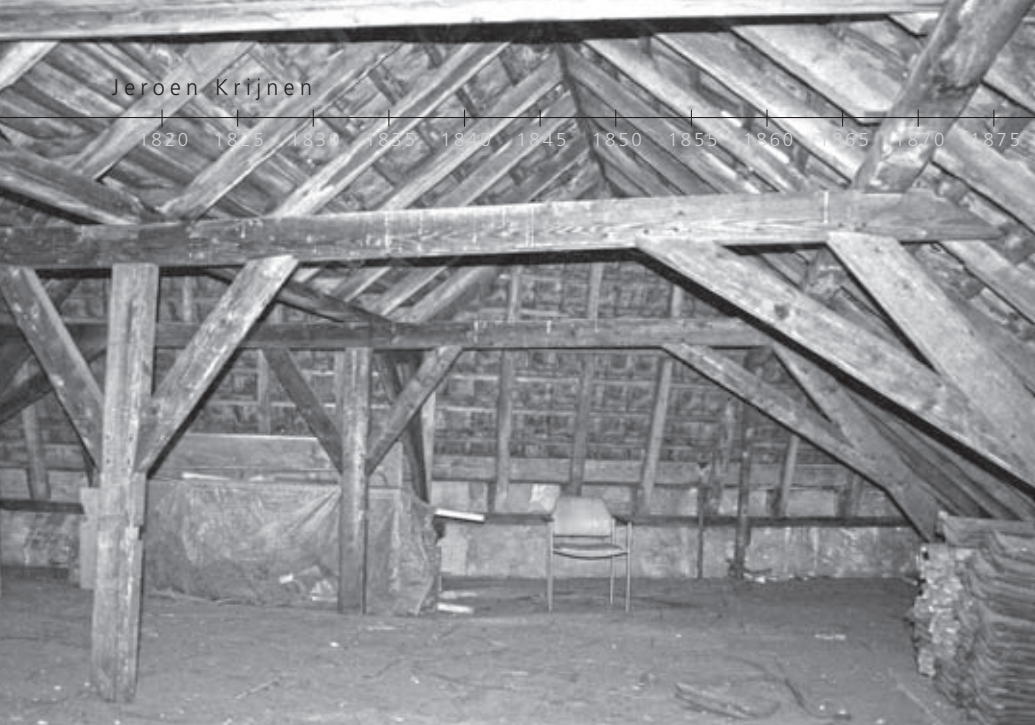
▲ De twee parallelle zadeldaken worden opgevangen door een grenen kapconstructie met makelaars onder de goot. Foto Jeroen Krijnen – gemeente Zutphen
