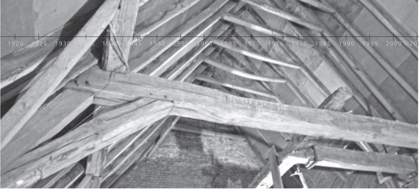
▲ De daksporen zijn van muurplaat tot nok uit één lengte gezaagd en zijn ca. 8,30 meter lang.
