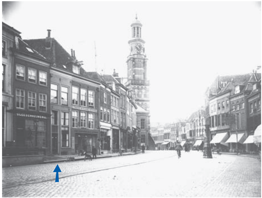
▲ Zicht op Houtmarkt en Groenmarkt rond 1920. De pijl markeert nummer 58, hier nog met hoge deur- en vensterpartij op de begane grond en de hoge kap. Foto collectie Stedelijke Musea Zutphen
