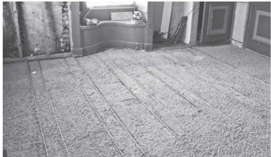
▲ De verdiepingsvloer na het opbrengen van Fermiculiet. De stalen L-profielen ter versterking van het gespelderd plafond eronder komen juist nog boven deze brandwerende isolatielaag. Foto Hendrik Haafkens – gemeente Zutphen
