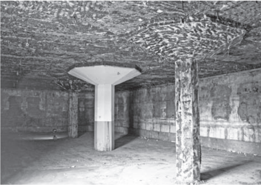
▲ Overzicht van de 2 e verdieping van het koelhuis met twee paddestoelkolommen. Eén kolom blijft voorzien van isolatie. Foto Jeroen Krijnen - gemeente Zutphen 2011
