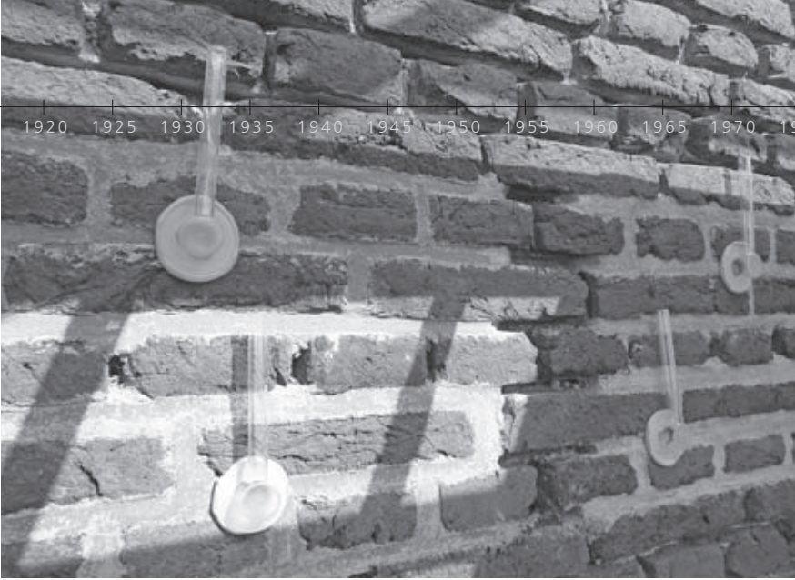
◀ Met buisjes van Karsten wordt de mate van opname en afdracht van vocht in het metselwerk bepaald.
