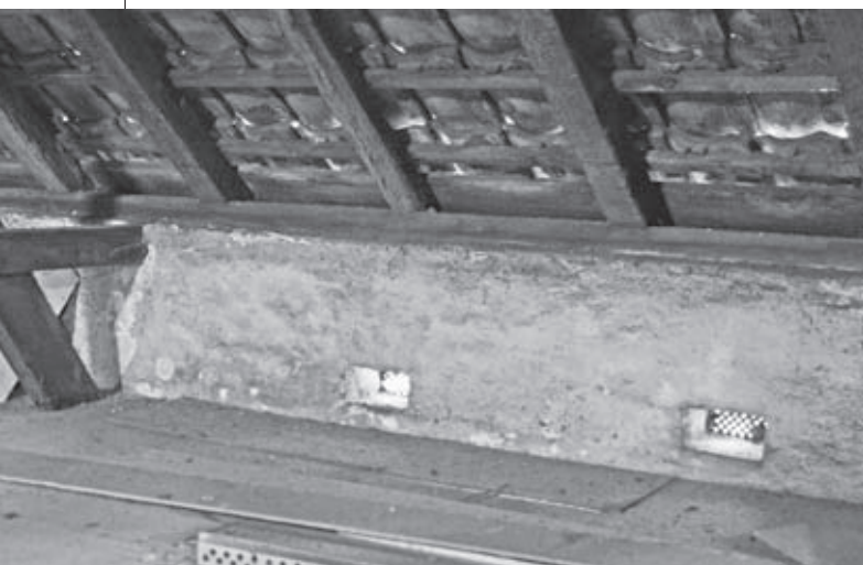
▲ In de borstwering aan de voor- en aan de achterzijde zijn juist boven de zoldervloer ventilatieroosters opgenomen. Foto Jeroen Krijnen – gemeente Zutphen
