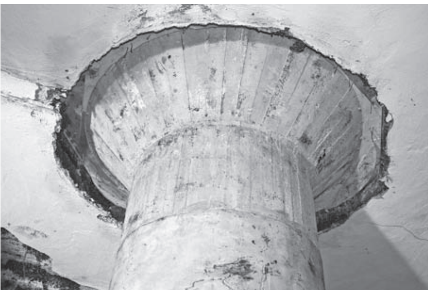
▲ Een detail van de mushroom-vloerconstructie in de kelder na verwijdering van de isolatielaag op de kolom. De sporen van de verloren bekisting tekenen zich in het beton af. Foto Jeroen Krijnen – gemeente Zutphen 2011
