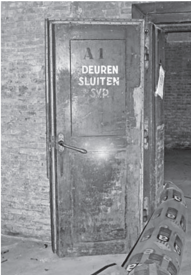
▲ Het interieur bevat een aantal originele onderdelen uit 1920, zoals houten isolatiedeuren van een halve meter dik. Foto Ben Kooij - RCE 2011
