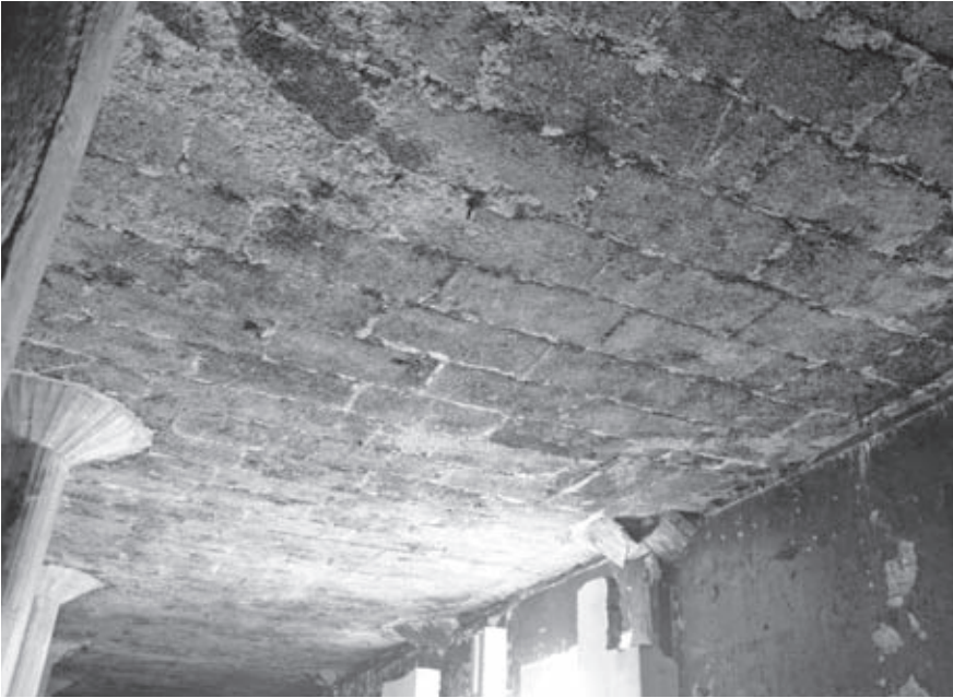
▲ Overzicht van het plafond van de eerste verdieping met de aftekening van de verwijderde kurk-isolatieplaten. Foto Jeroen Krijnen – gemeente Zutphen 2011
