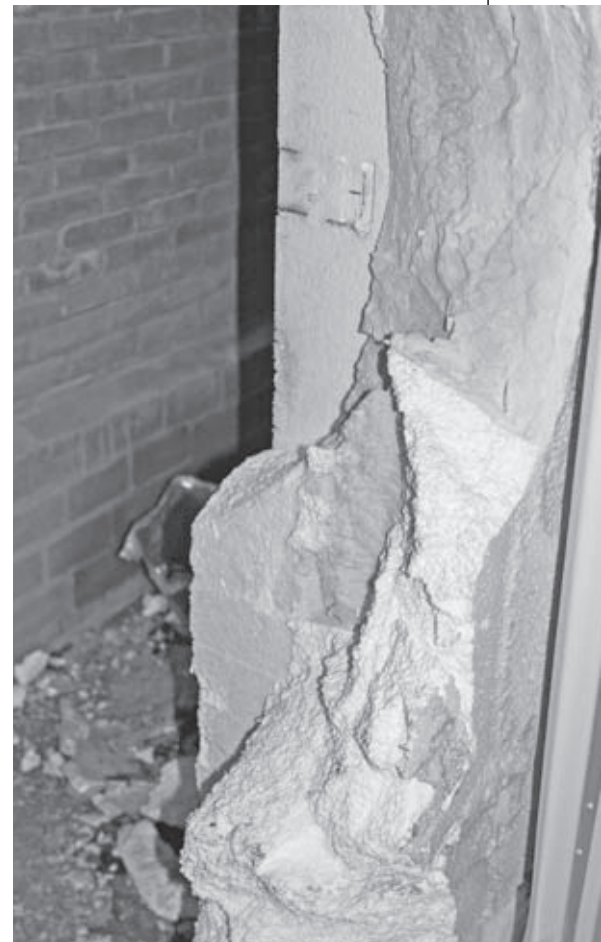
▲ Foto van 42 cm moderne isolatie in de uitbreiding van 1984.
