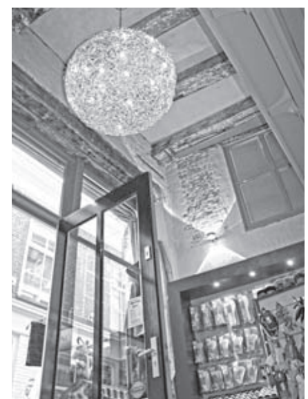
▲ De circa viereeneenhalve meter hoge begane grond na de renovatie. Rechts is juist de insteek insteek zichtbaar.
