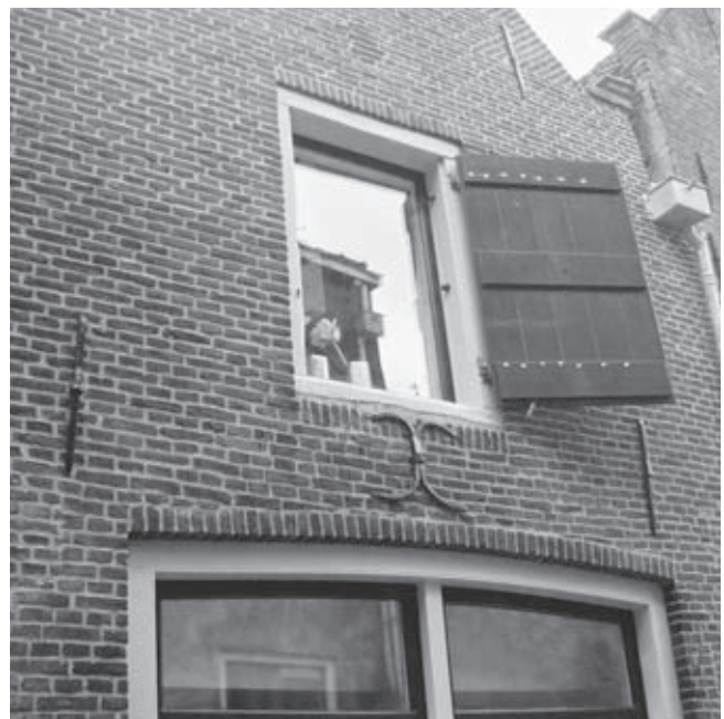
▲ Het oorspronkelijke sluitwerk van het luik moet nog worden bijgeplaatst. De klampen worden nog iets aangepast voordat het geheel wordt afgelakt. Foto Lisette van Loosen – gemeente Zutphen
