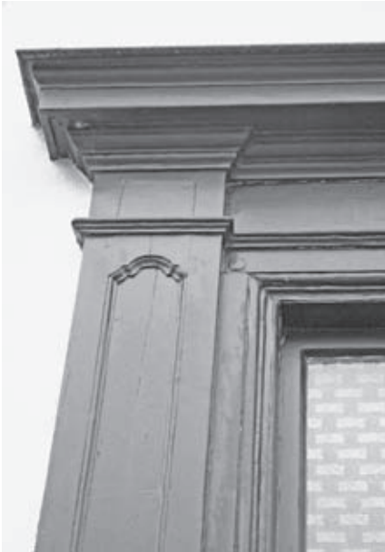
▲ Detail van de pilasterstelling.
