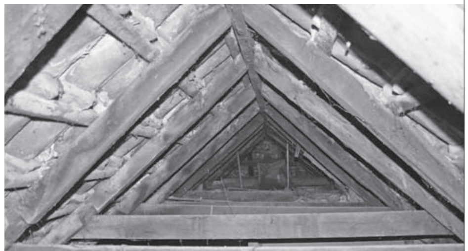
▼ Voor de kap zijn in de 19e eeuw hergebruikte eiken daksporen toegepast. De dakpannen waren vanaf de onderzijde aangesmeerd om regen en sneeuwdorslag te voorkomen. Geheel links op de foto zijn de bouwsporen van hergebruik goed zichtbaar. Foto Jeroen Krijnen – gemeente Zutphen
