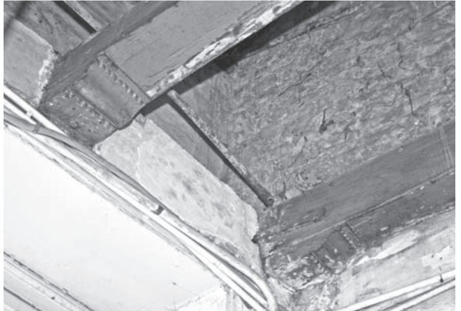
▲ Detail van de zolderbalklaag met geprofileerde consoles uit de 17e eeuw.
