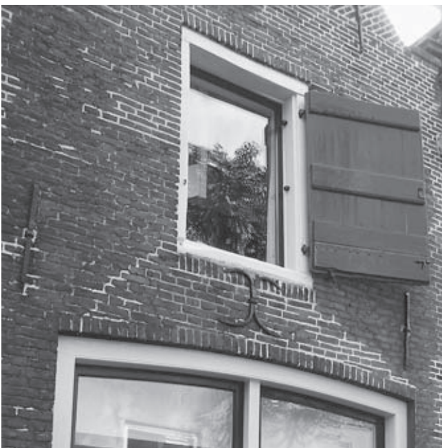
▲ Het oorspronkelijke sluitwerk van het luik moet nog worden bijgeplaatst. De klampen worden nog iets aangepast voordat het geheel wordt afgelakt. Foto Lisette van Loosen – gemeente Zutphen
