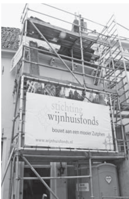
▲ Werk aan Oudewand 51 in uitvoering. Foto Hendrik Haafkens - gemeente Zutphen
