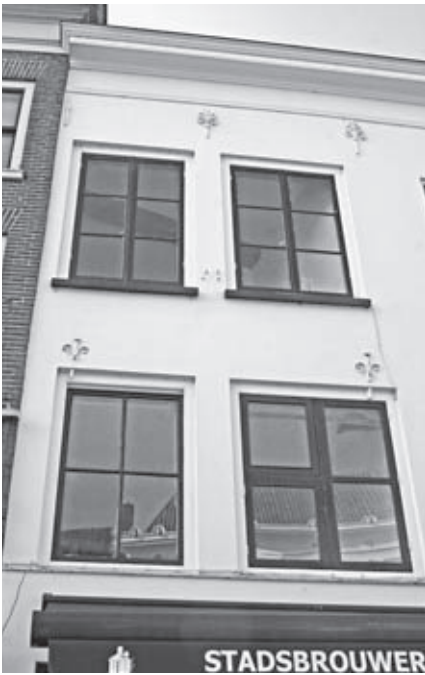
▲ De gevel van nummer 58 is nog voorzien van 17e-eeuwse muurankers. Foto Jeroen Krijnen – gemeente Zutphen
