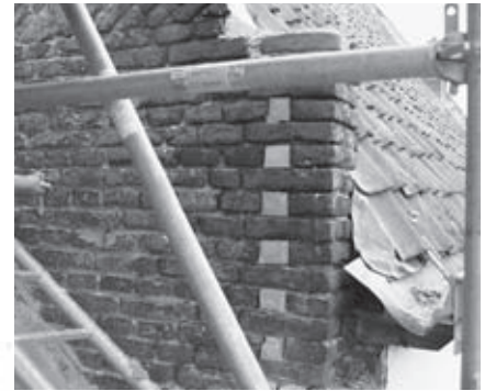
▲ Ook de topgevels dateren uit ca. 1640. De gevelschouders hebben een hoekoplossing die is gemetseld met klezoren (geaccentueerd).
