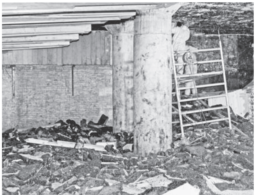
▲ Tijdens de sloop van de isolatieafwerking in het Koelhuis kwam een penetrante, aan teer denkende stank vrij. Foto Ben Kooij - RCE 2011
