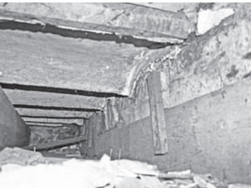
▲ Het gespelderde plafond is aangebracht tussen de bestaande kinderbinten van de verdiepingsvloer. Tegen de bovenrand van de foto is juist een overhoeks afgeschuinde kinderbint zichtbaar.
