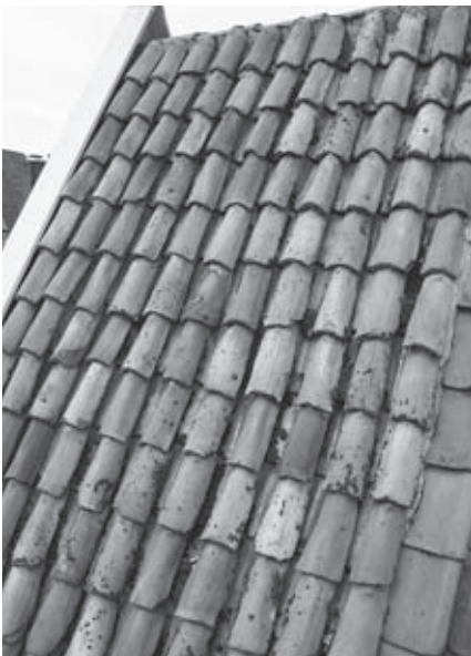
▲ Als onderdeel van de restauratie van de bovenwoning van Lange Hofstraat 21 is een deel van het dak bedekt met middeleeuwse holle en bolle pannen. Dit type dakpan moet in de 15e en 16e eeuw het dakenlandschap van Zutphen bepaald hebben en zal ook op het dak van Nieuwstad 4 gelegen hebben.
