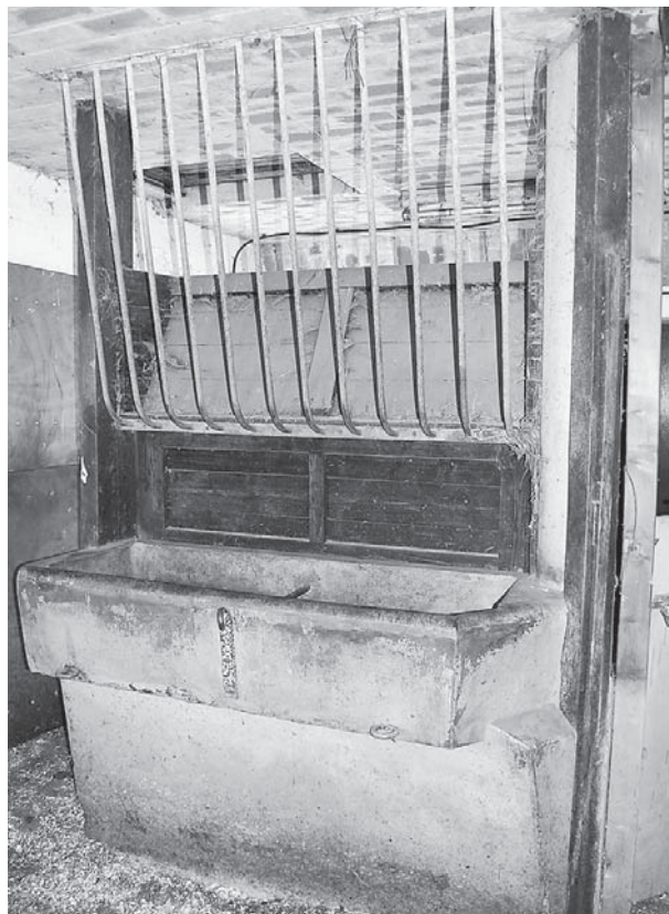
◀ Paardenstal met ruif in de aangebouwde vleugel van Lansinkweg 2.
