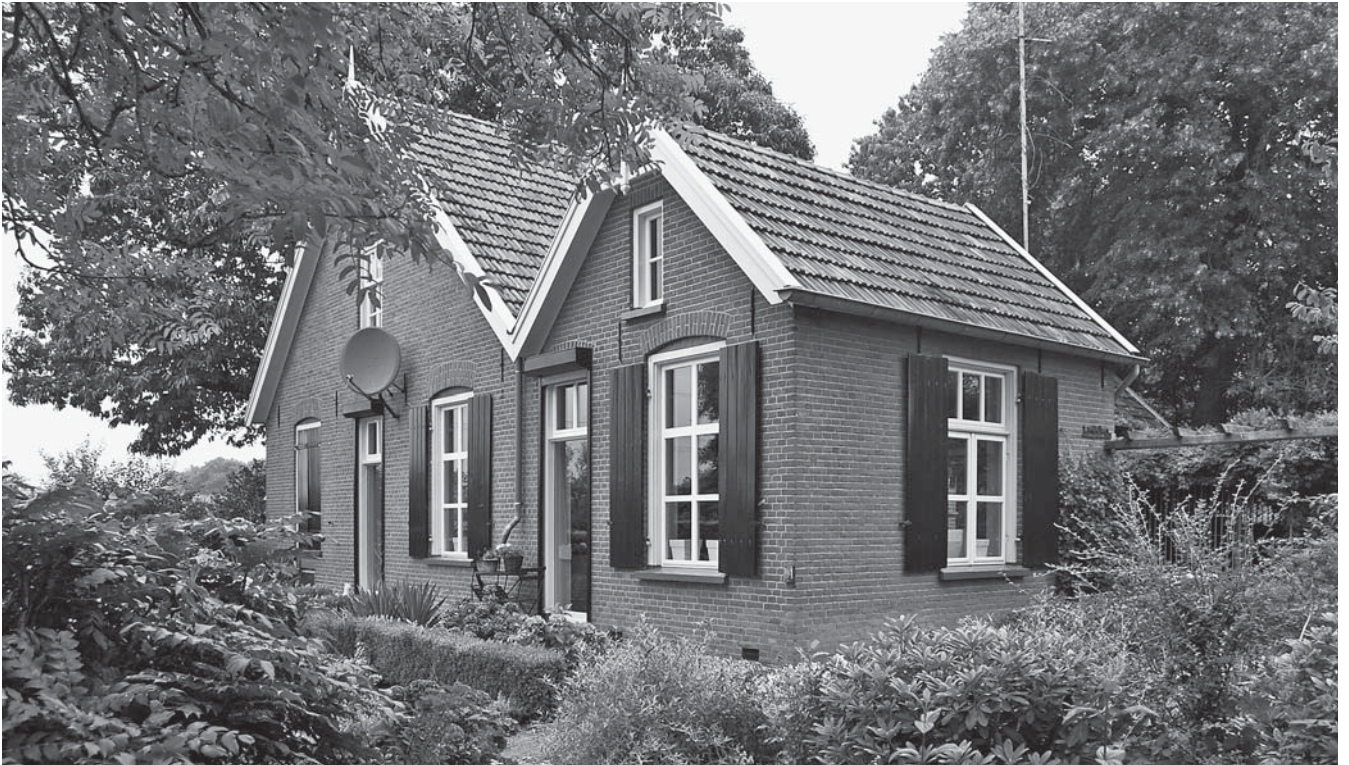
▲ Voorgevel van Vierakkersestraatweg 9 met rechts de aangebouwde kleermakerswerkplaats. Foto Peter Boer - Arcx
