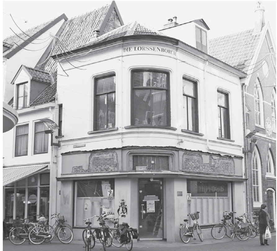
▲ Bij de verbouw van het pand "Die Lorscheborch" (d.w.z. het deel op het adres Beukerstraat 12) bleek de centrale entree uit de bouwtijd van het hoekpand (1858) nog aanwezig te zijn. Deze is gehandhaafd en gerestaureerd. Foto Jeroen Krijnen - gemeente Zutphen
