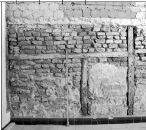
▲ Spitaalstraat 94. De vakwerkwand in de rechter bouwmuur.
