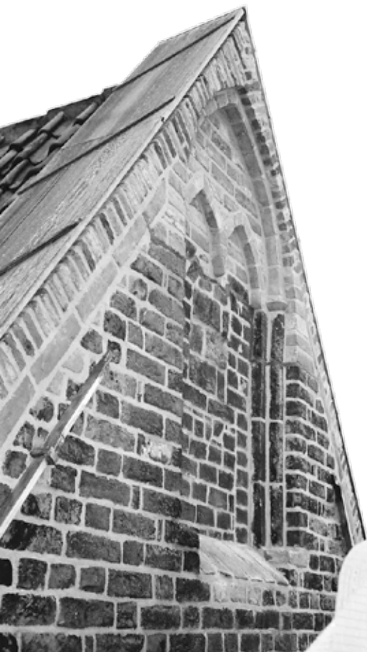
◀ De in 1999 gedeeltelijk gereconstrueerde rechter geveltop van Broederenkerkstraat 1-3 hoort vermoedelijk bij dezelfde bouwcampagne als waartoe de bouwmuur tussen dit pand en Spiegelstraat 2 behoort en is waarschijnlijk tussen 1275 en 1325 gebouwd. Foto Jeroen Krijnen – gemeente Zutphen
