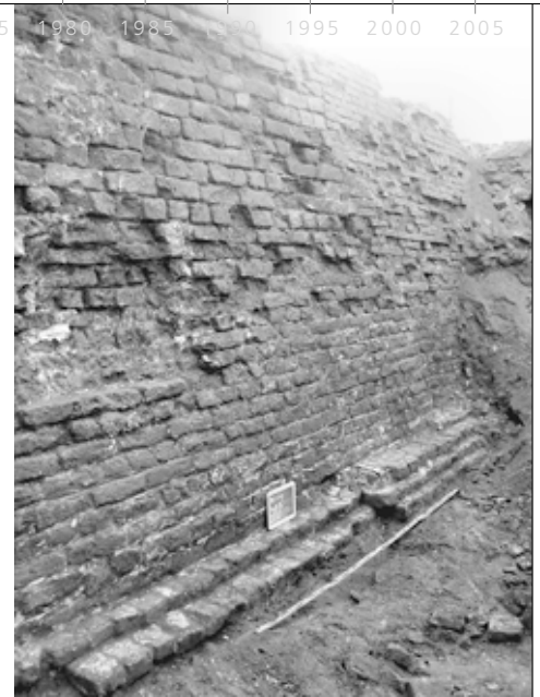
▲ De veldzijde van de stadsmuur. De 16 e -eeuwse verdikking van de muur is duidelijk onder een licht schuine hoek gemetseld. Er werden diverse steenformaten gebruikt. De veldzijde is door verwerking en mogelijk ook door beschieting aangetast.
