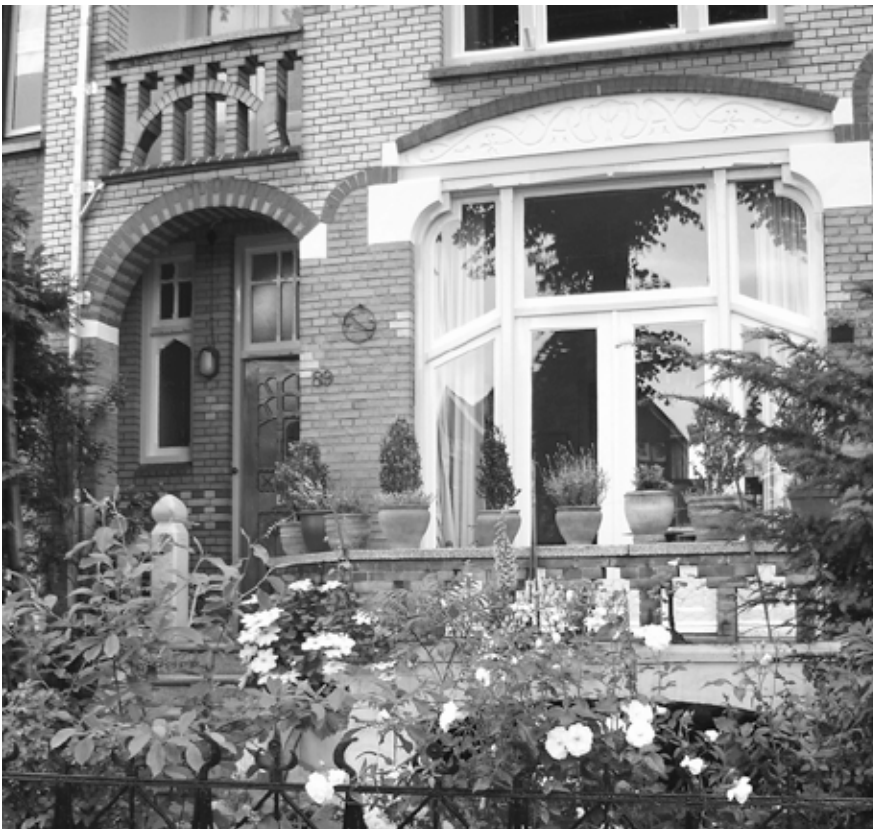
▲ Detail van de voorgevel met oorspronkelijk tuinhek in Jugendstil-vormen
