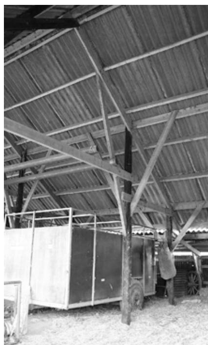
▼ Deel van de constructie van de voormalige hooitas. De zwartgeblakerde delen zijn na de brand van 1966 gehandhaafd, op de voorgrond één van de hergebruikte roeden van een hooiberg.
