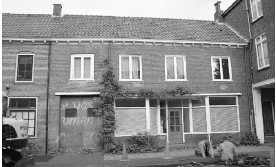
▲ Laarstraat 119. Bij de bouw van het nieuwe gedeelte in 1939 is aansluiting gezocht bij het oudste deel van de gevel links met de wagendeuren.
