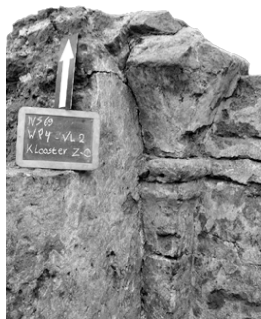
▲ Aanzet van het kruisgewelf van de kelder onder de kloostervleugel.
