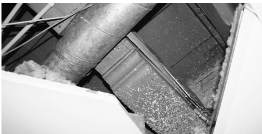
▲ Achter het verlaagde systeemplafond is de historische balklaag met sleutelstukken nog aanwezig. De locatie is met een cirkel op de plattegrond aangegeven. Foto Jeroen Krijnen – gemeente Zutphen
