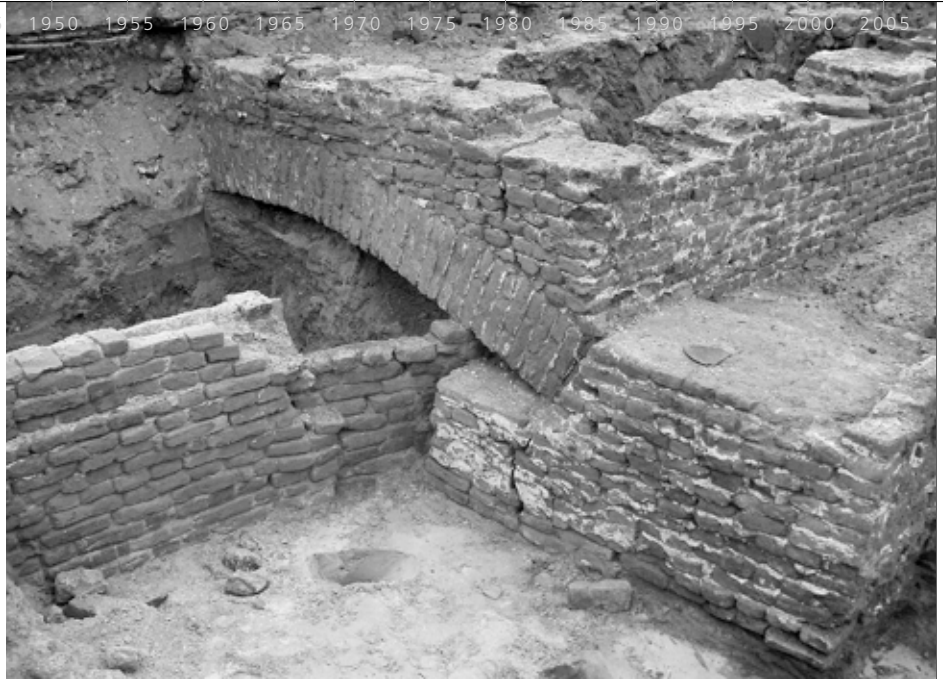
▲ Op deze foto is goed te zien dat de 15 e -eeuwse vleugel van het klooster door middel van een spaarboog over de voormalige brouwoven is gemetseld. De oude ovenruimte (links achter de muur) deed in de kloostertijd nog enige tijd dienst als beerput.
