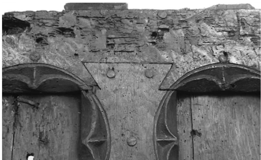
▲ Detail van de voorzijde met de zwaluwstaartverbinding van de middenstijl met de bovenregel. Foto Michiel van den Ent - Zutphen
