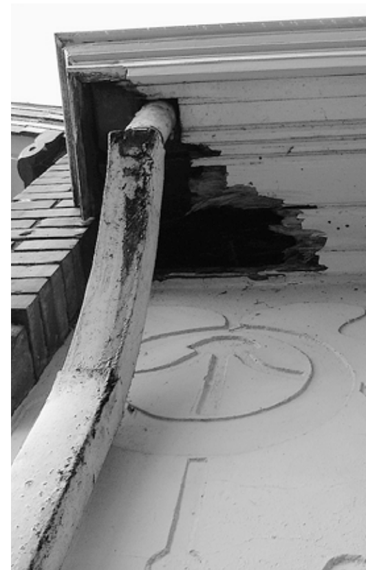
▲ Impressie van de schade: doorgerotte gootonderzijde
