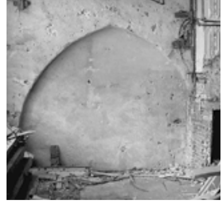
▲ Een 13 e -eeuwse spitsboogvormige spaarnis op de begane grond aan de westzijde, direct achter de voorgevel.
