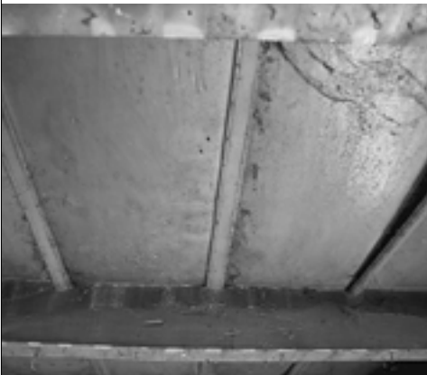
▲ De onderzijde van de zoldervloer van het eerste achterhuis, boven de zaal. De naden tussen de brede eiken vloerdelen zijn bij de bouw afgedekt met geprofileerde vuren latjes om stofneerslag te voorkomen.
