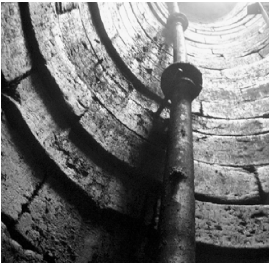
▲ Een blik in de put. We zien hier de 19e-eeuwse gietijzeren buis langs de middeleeuwse trachietblokken. Foto Bureau Archeologie gemeente Zutphen
