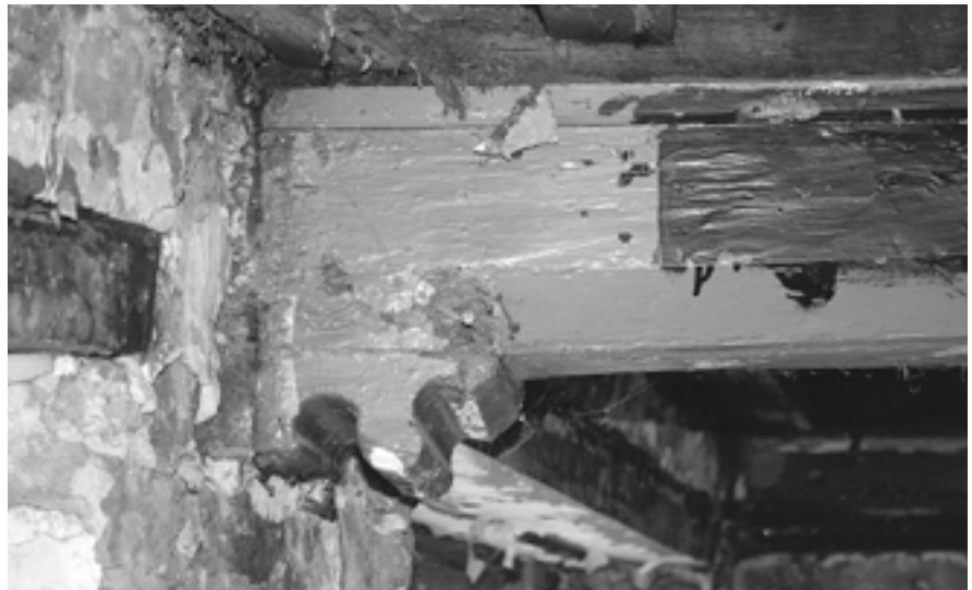
▲ De oorspronkelijke zoldervloer van het hoofdhuis van Laarstraat 59 bestaat uit moer- en kinderbinten met peerkraalsleutelstukken. Zij dateren de balklaag globaal in de 15 e eeuw.
