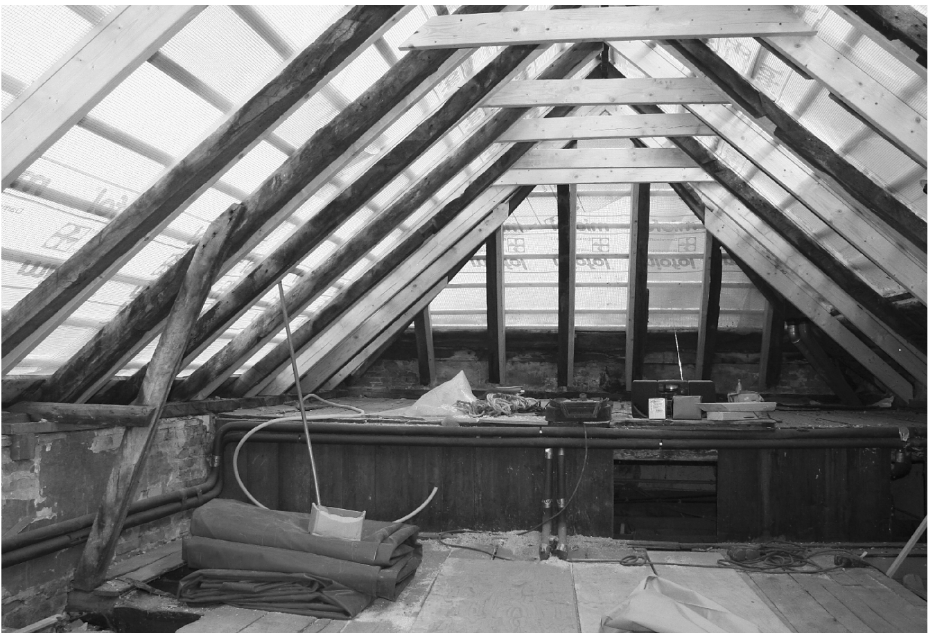
▲ De kap tijdens de werkzaamheden. Foto J.S. Krijnen – Gemeente Zutphen
