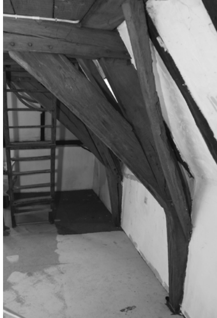
▲ Detail van het middelste gebint van de eiken kapconstructie, dendrochronologisch gedateerd op herfst/winter 1577 en in 1579 geplaatst. Foto Frans Leuring – Werkgroep Bouwhistorie Zutphen
