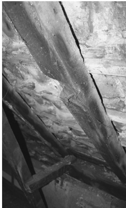
▲ Eiken dakspoor, in de 19e eeuw opnieuw toegepast en een kwartslag gedraaid. Foto J.S. Krijnen – Gemeente Zutphen
