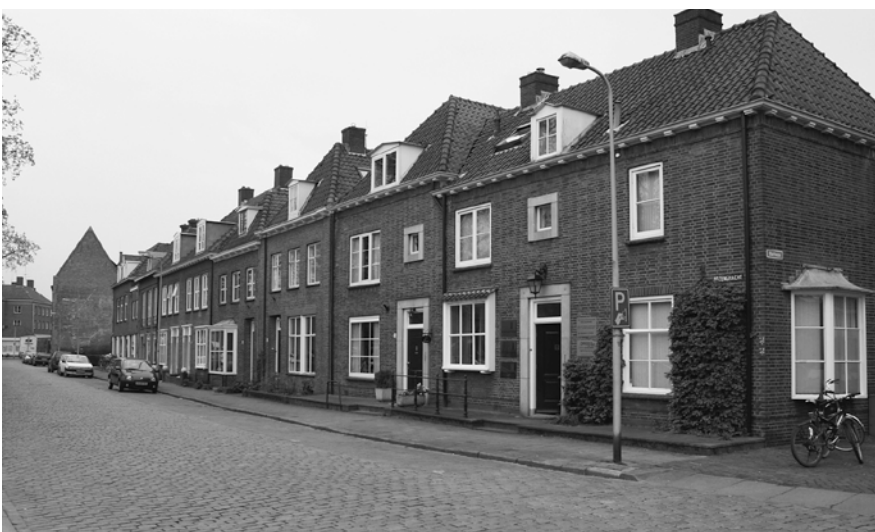
▲ Gevelwand aan de Rozengracht. foto J.S. Krijnen – Gemeente Zutphen
