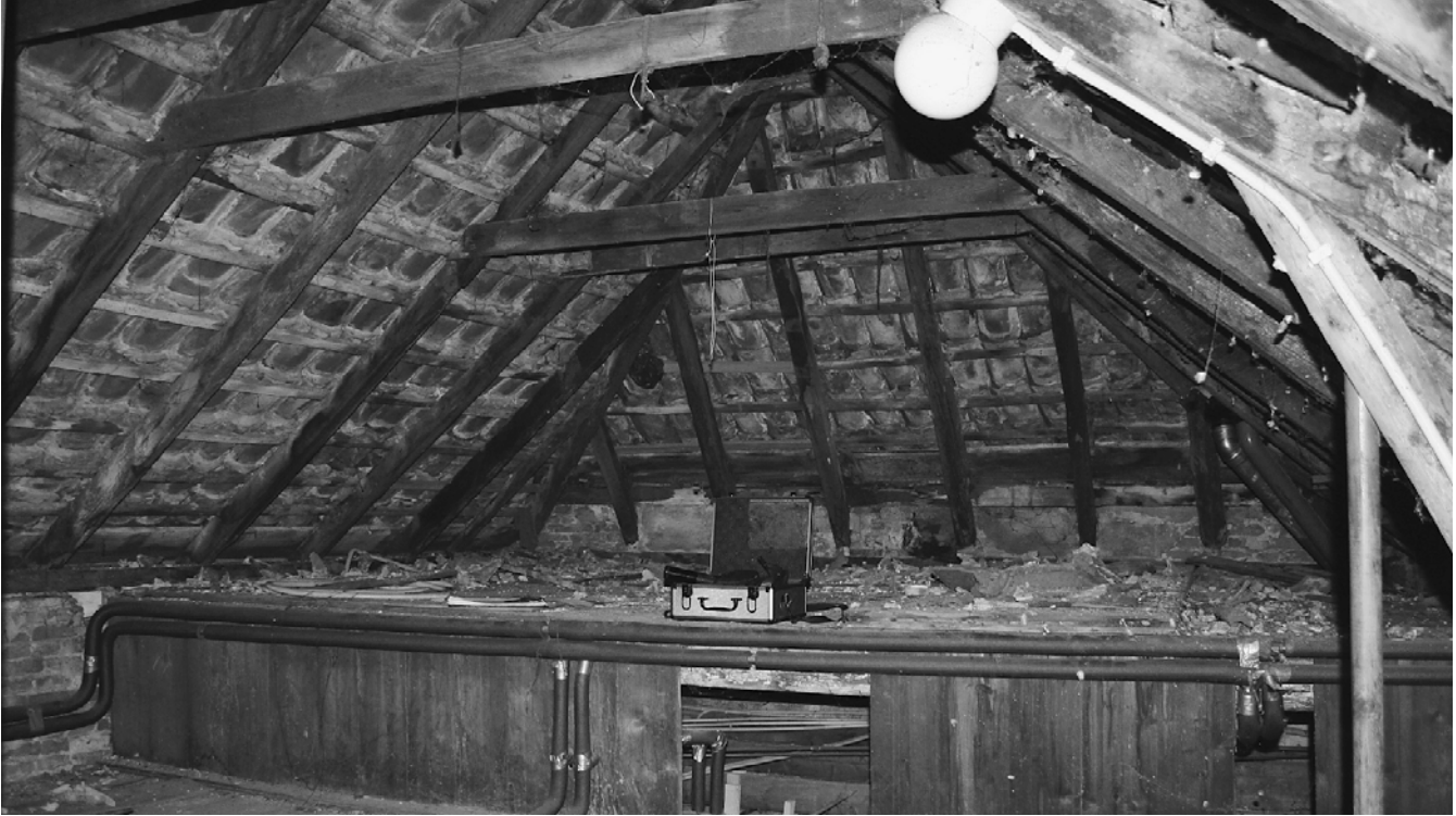
▲ De onbeschoten kap met aangesmeerde dakpannen vrij in het zicht. Foto J.S. Krijnen – Gemeente Zutphen
