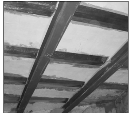
▲ Keukenvloer: klaar! De stalen nagels voor de galvanische verbinding tussen zinkplaat en stalen ligger zijn nog net zichtbaar
