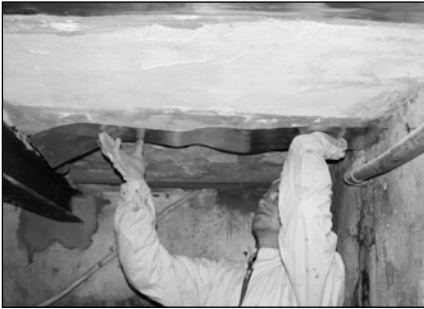
▲ Het aanbrengen van de zinkstroken met gel
