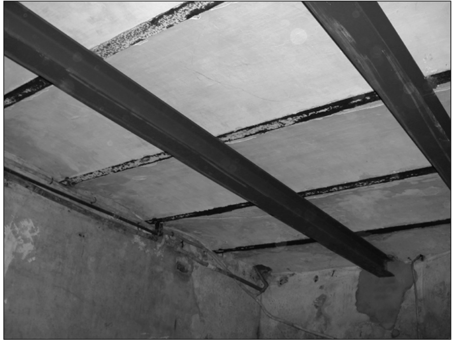
▲ Keukenvloer van onderen; de extra ondersteunende balken zijn al aangebracht
