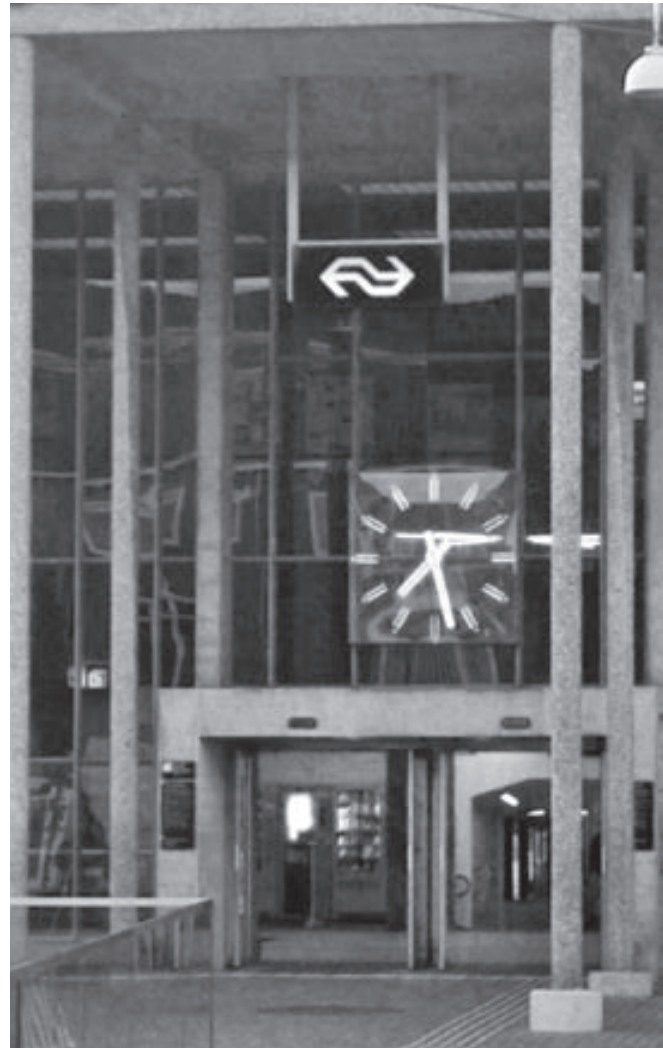
▲ Het vertrouwde beeld weer hersteld. Lampjes werden vervangen, wijzerring en wijzers kregen een nieuwe laagje goudverf.
