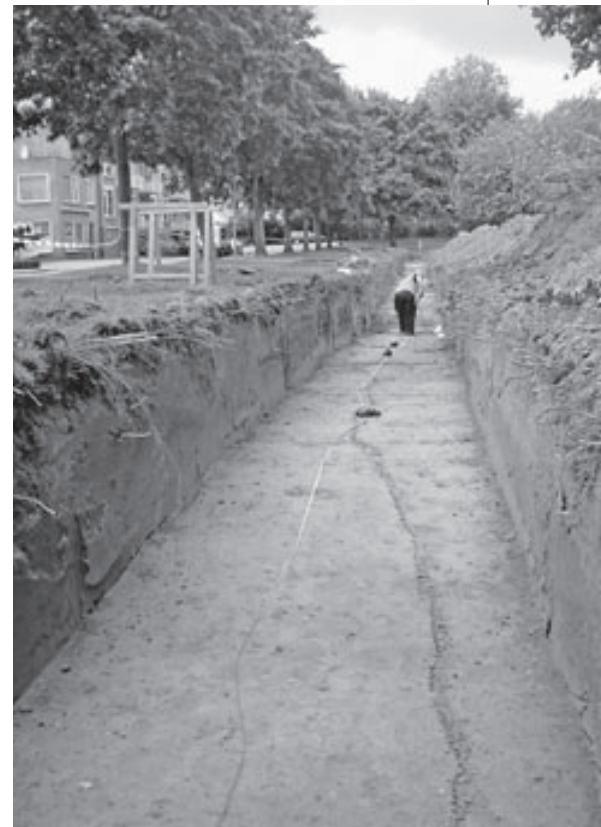
▲ Spittaalderkamp: de proefsleuf.
