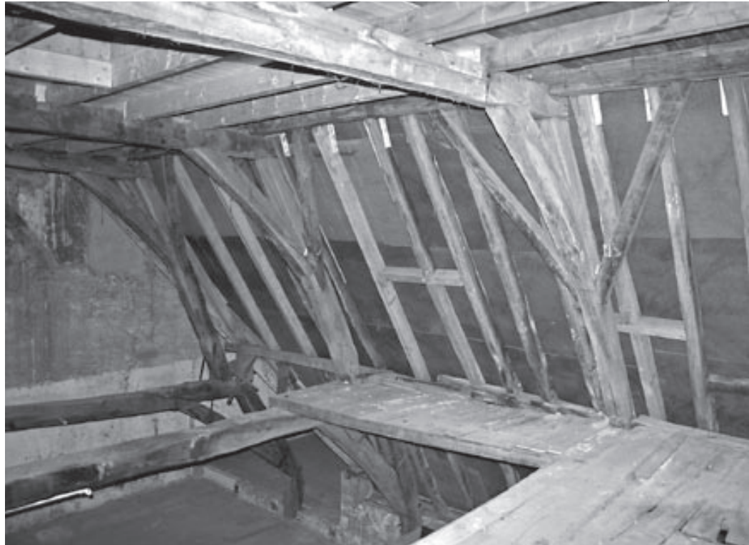
▲ De eiken kapconstructie met gestapelde gebinten met gekromde spantbenen beneden en rechte spantbenen boven.
