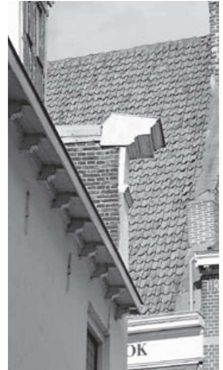
▲ De achterzijde van de lijstgevel vanuit de Heukestraat. Behouden gebleven eerste trede van een vermoedelijk 17e-eeuwse trapgevel met klezortjes als hoekverband.
