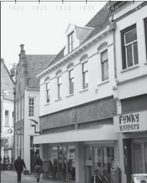
▲ Voorgevel Sprongstraat 12-14 na de restauratie.
