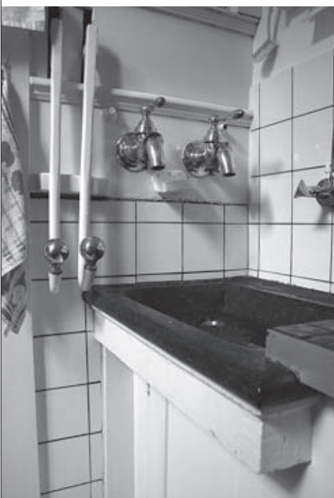
▲ De hardstenen gootsteen in de keuken met messingen kranen en pompzwengels.
