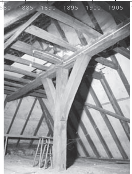
▲ De kapconstructie op vlieringniveau met zicht op de ondersteuning van de middelste flieringbalk. Eén van de schuine schoren is in het verleden verwijderd.
