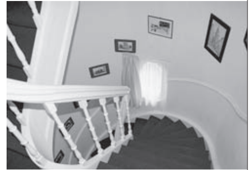
▲ Engelse trap met open schalmgat. De kleine achzijdige vensters zorgen voor daglicht.
