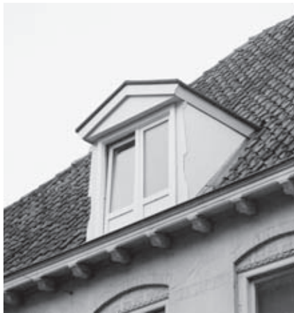
▲ Bij de restauratie van Sprongstraat 12-14 is ook de bestaande in trespa uitgevoerde dakkapel vervangen.
