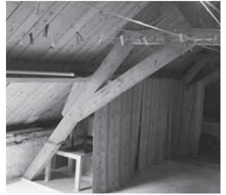
▲ Grenen dekbalkgebint op zolder met dakbeschot uit de bouwtijd.
