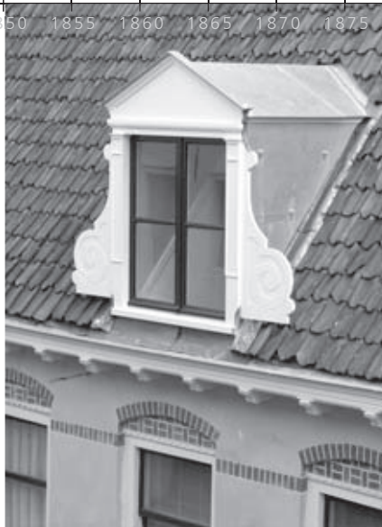
▲ De dakkapel na restauratie. Ook de baksteenornamentiek boven de vensters is weer in ere hersteld.
