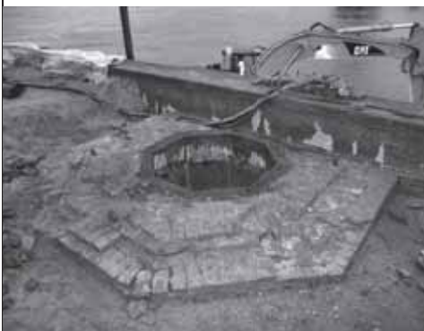
▲ De fundering van de gietijzeren kraan op de IJsselkade
