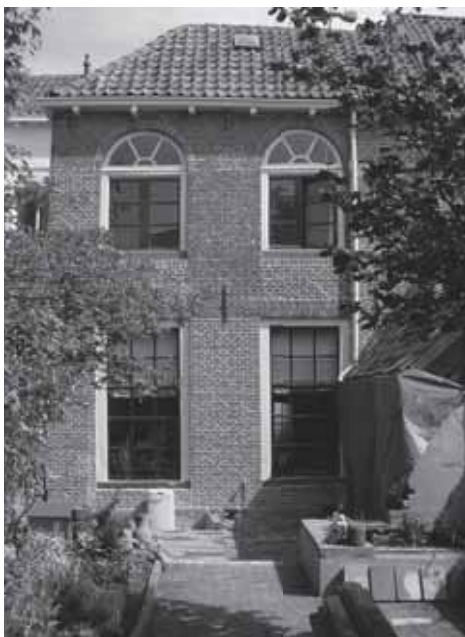
▲ De tuingevel van Kolenstraat 35 na gevelrestauratie. Foto Venema Gevelrestauratie
