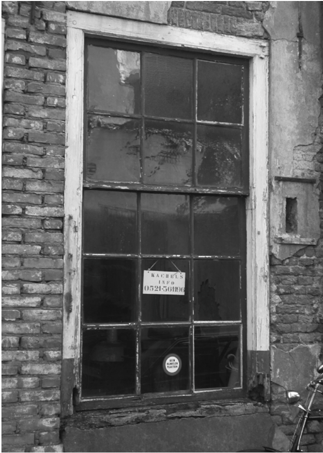
▲ Fraai maar vervallen voorbeeld van een oorspronkelijk met vast kalf uitgerust schuifvenster in de Kolenstraat. Het onderste deel van de stijlen is voorzien van een sponning voor de buitenluiken en de plaats van het verdwenen kalf tekent zich duidelijk af in de verf.
