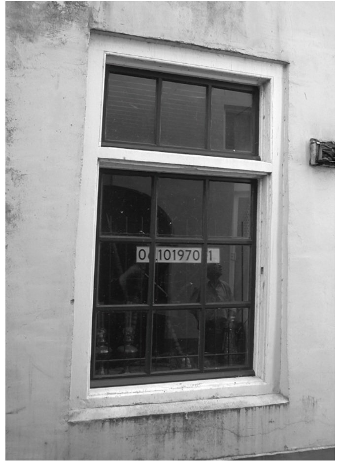
▲ Nog vrijwel compleet schuifvenster met vast kalf in de voorgevel van Heukestraat 51 in Zutphen. De luiken ontbreken, maar de plaats van de duimen van de gehengen is nog goed te zien, net zoals de uitsparingen in de stijlen van de klamp om de luiken af te sluiten.
