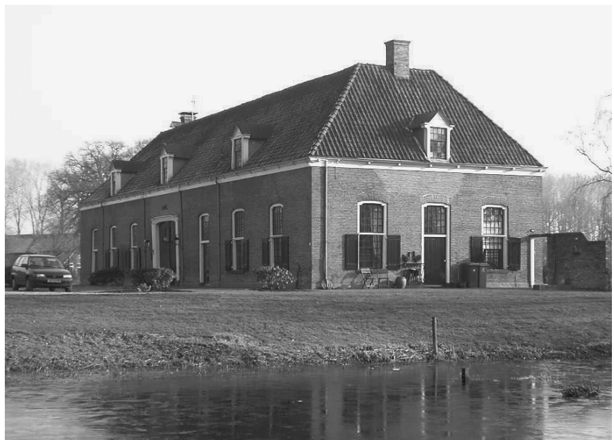
▲ Een zeer fraai voorbeeld van een pand met nog geheel in de oorspronkelijke vorm bewaarde schuifvensters met vaste kalven is het voormalige bouwhuis van de Nettelhorst bij Lochem dat dateert uit 1760.
