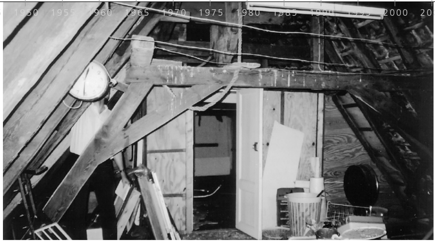
▲ Eén van de grenen schaarspanten op zolder. Bovenaan de foto is nog juist een deel van het hijsrad zichtbaar. Foto J.S. Krijnen – gemeente Zutphen
