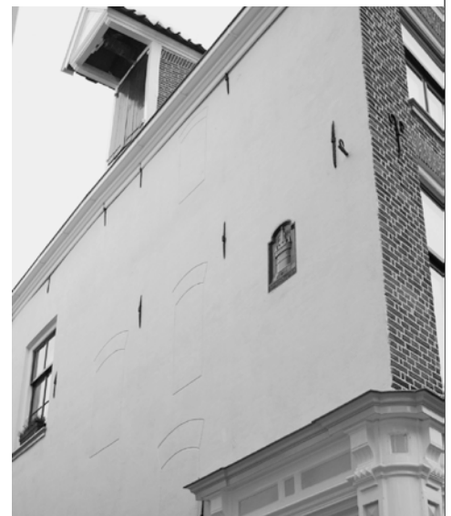
▲ Zijgevel aan de Rodetorenstraat met de herplaatste gevelsteen en de 14e-eeuwse vensters in het stucwerk aangegeven.
