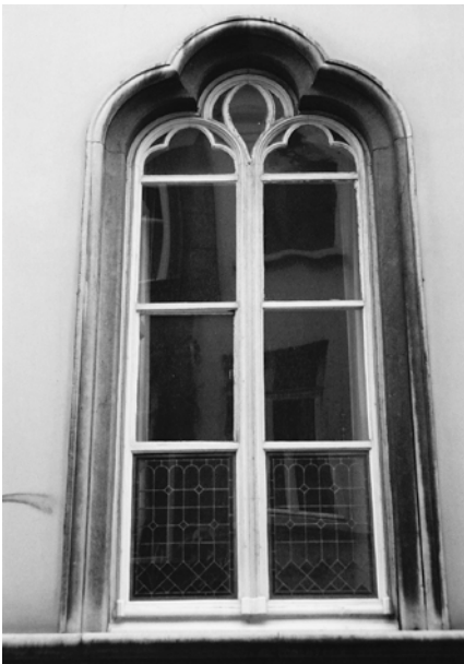
▲ Met dun isolatieglas kan een bewerkelijke, fijn gedetailleerde raamvulling zoals dit voorbeeld in Gent behouden blijven. Foto J.S. Krijnen
