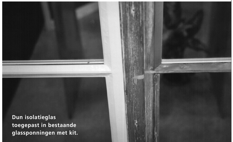
▲ Dwarsdoorsnede van het Ruysdaelglas in een bestaande glassponning. Duidelijk is de kit zien die toegepast wordt als de oude stopverf. afbeelding Ruysdaelglas
